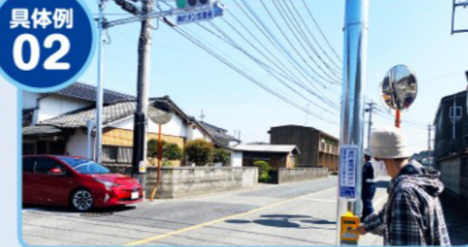
県道豆田稲築線 信号機設置
